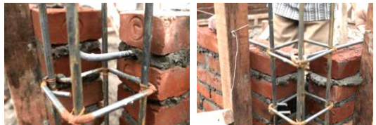
Gambar 3. 27 Pemasangan Angkur Besi Sebagai Pengikat Antara Kolom
