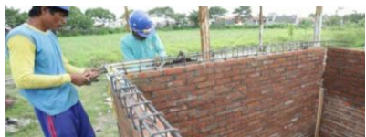
Gambar 3. 34 Perangkaian Tulangan Balok Keliling/Ring di atas Dinding
