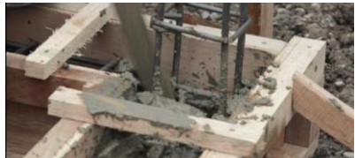
Gambar 3. 32 Pengecoran Balok Pengikat/Sloof
