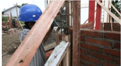
Gambar 3. 33 Proses Pengecoran Kolom
