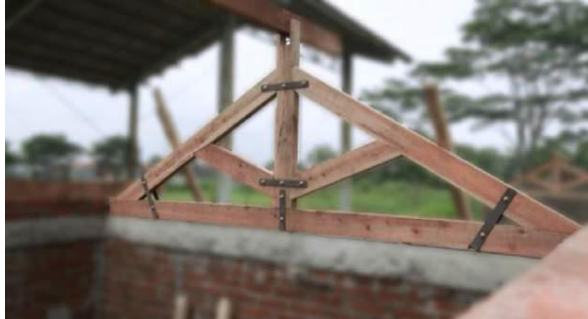
Gambar 3. 15 Pemasangan Plat Baja pada Kuda-Kuda Kayu
