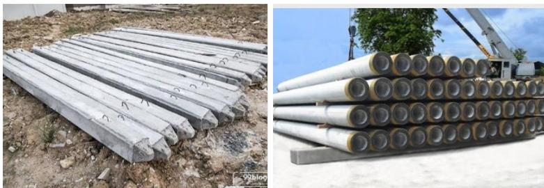
**Gambar 2. 17** Pondasi Tiang Pancang Beton
