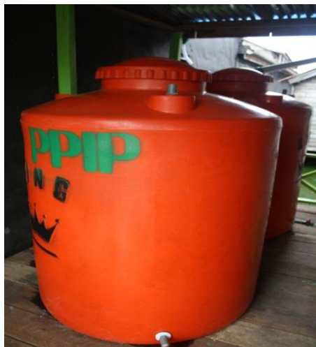
Gambar III.28. Bak PAH Terbuat dari Polyethelin
