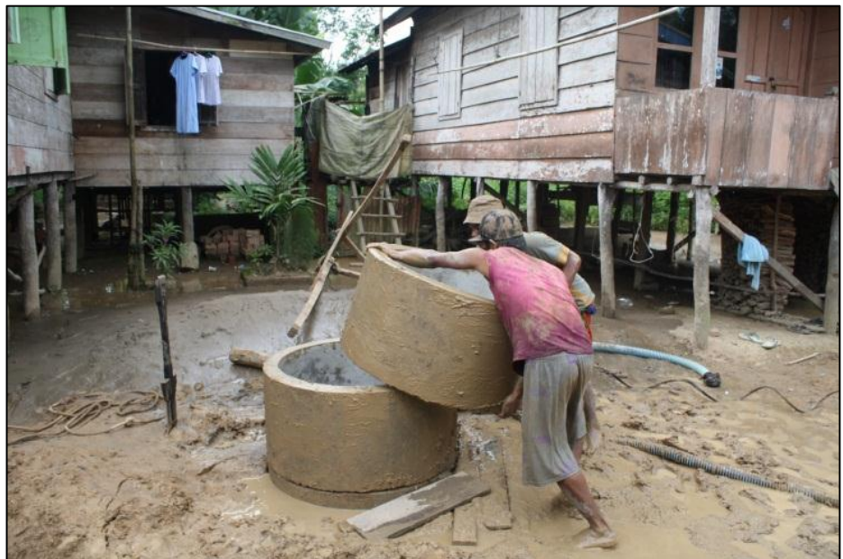
Gambar III.18. Foto Pemasangan Dinding Sumur Gali dengan Buis Beton
