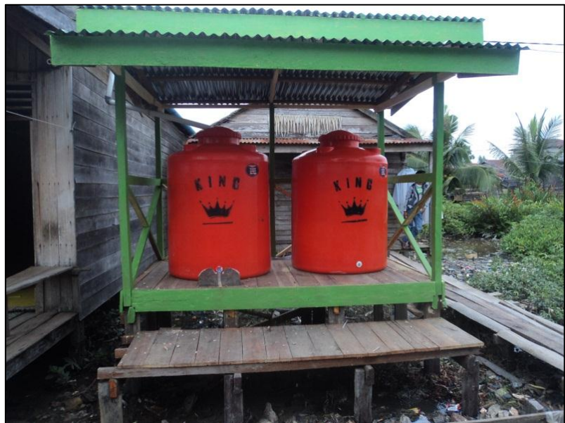
Gambar III.26. PAH yang Terbuat dari Polyethelin
