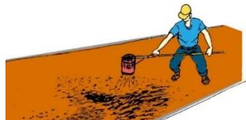
Gambar 3.17 Penyiraman Aspal pada Batu Pengunci
