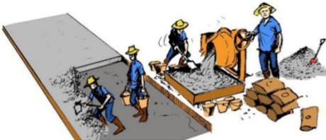
Gambar 3.25 Pencampuran dan Pengecoran Beton
