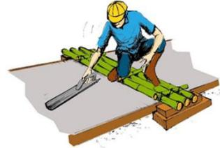
Gambar 3.28 Penghalusan Permukaan Beton
