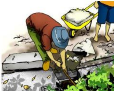
Gambar III.10 Pembersihan Sedimen Di Saluran Tertutup
