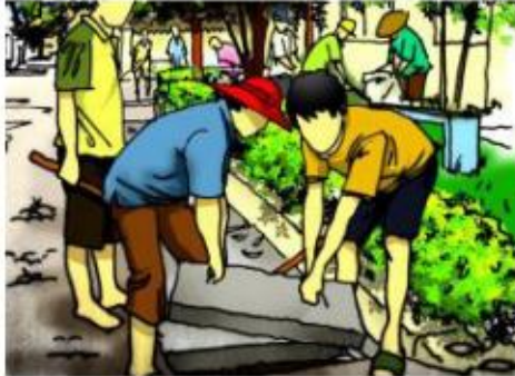
Gambar III.9 Membuka Tutup Saluran
