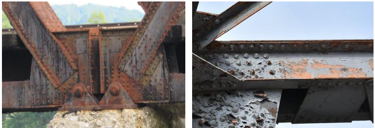
Gambar III.34 Karatan dan lapisan cat yang terkelupas
