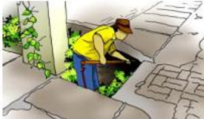
Gambar III.13 Penggalian Sedimen Di Gorong-Gorong Berukuran Kecil
