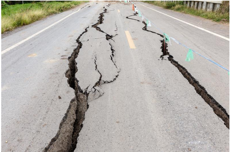
Gambar III.25 Penurunan Setempat ( Deformation )
