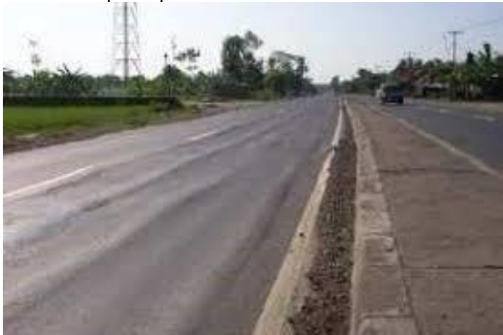
Gambar III.19 Alur ( Ruts ) Tanpa Retak
