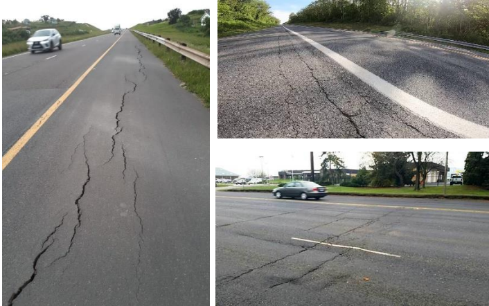
Gambar III.17 Retak Garis Memanjang dan Melintang
