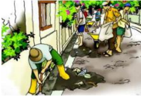
Gambar III.4 Pengangkatan Sedimen Di Saluran
