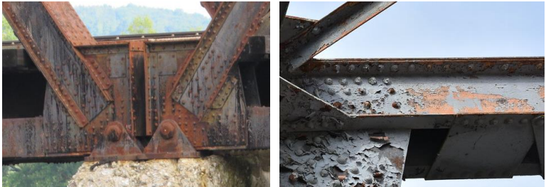
Gambar 3. 34 Karatan dan lapisan cat yang terkelupas
