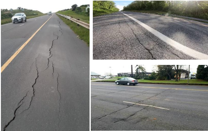
Gambar 3. 17 Retak Garis Memanjang dan Melintang
