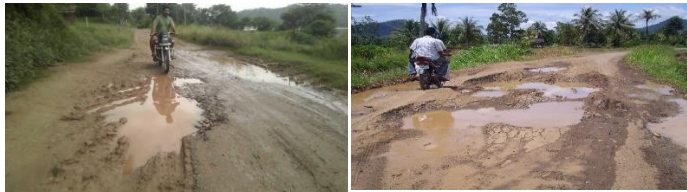
Gambar 3. 28 Lubang (Pot Holes)
