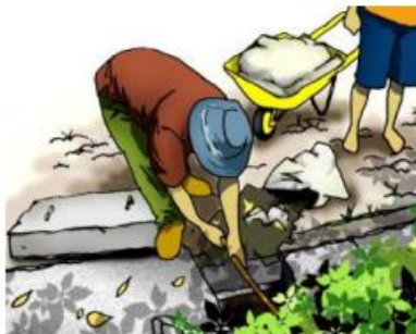
Gambar 3. 10 Pembersihan Sedimen Di Saluran Tertutup
