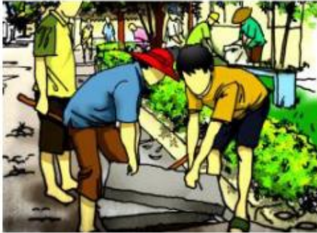
Gambar 3. 9 Membuka Tutup Saluran
