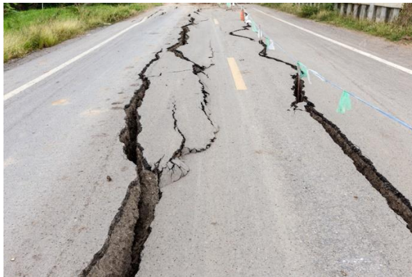
Gambar 3. 25 Penurunan Setempat ( Deformation ) Sumber: Google
