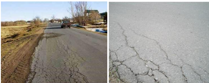
Gambar 3. 21 Kerusakan Tepi (Edge Break) Sumber: Google
