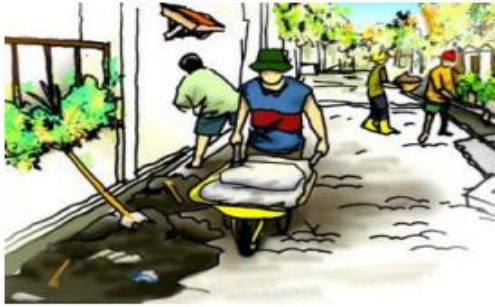
Gambar 3. 6 Pengangkutan Karung Sedimen Ke TPS Sumber: 12/PRT/M/2014 tentang Penyelenggaraan System Drainase Perkotaan, Peraturan Menteri Pekerjaan Umum
