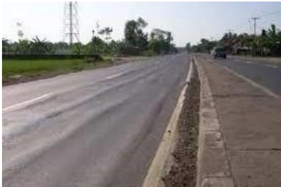
Gambar 3. 19 Alur ( Ruts ) Tanpa Retak Sumber: DPU Kulon Progo
