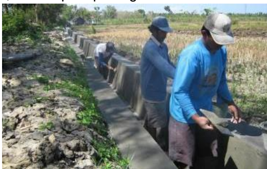
Gambar IV.22 Pembangunan Saluran Irigasi dengan Pasangan Batu
