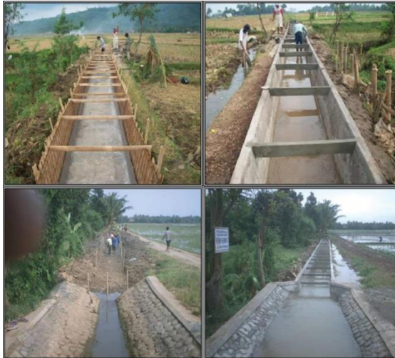
Gambar IV.24 Pembangunan Saluran Irigasi dengan Beton Modular
