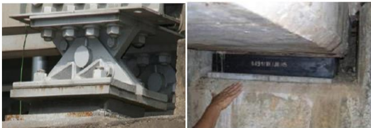
Gambar 2.8 Landasan Jembatan
