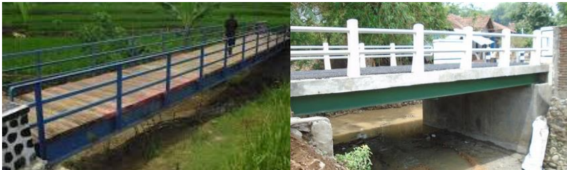
Gambar 3.5 Jembatan Komposit Gelagar Baja Lantai Kayu dan Lantai Beton
