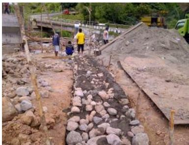
3. **Pekerjaan Tembok Penahan Tanah**, Biasanya untuk menahan oprit, pasangan batu sering dipakai untuk pekerjaan. tetapi pada kondisi tertentu dengan ketinggian pasangan yang lebih
