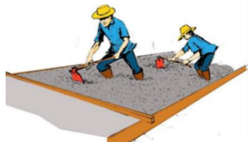
Gambar 3.18 Penghamparan dan Pemadatan Beton
