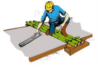
Gambar 3.20 Penghalusan Permukaan Beton
