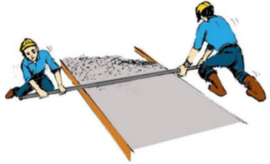
Gambar 3.19 Perataan Permukaan Beton
