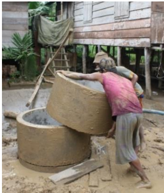
Gambar III.3 Pemasangan Dinding Sumur Gali dengan Buis Beton
