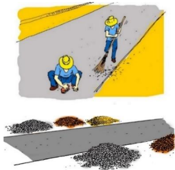
Gambar 3.6 Cara Kerja Perkerasan Jalan Lapen
